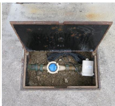
水道メーターの設置施工例
